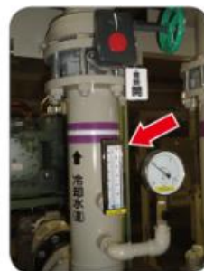
写真-F 冷却水出口温度
