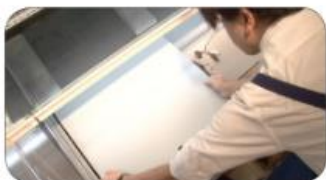
ショーケースの床板をはずします。
