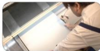
床板を外します
