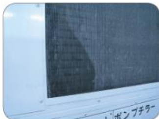
熱交換器の油のじみ
