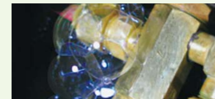
発泡液で漏えいを確認
