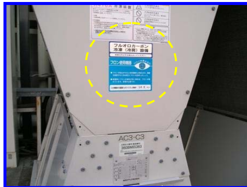
場所：研究棟設備ハッケージ（室外機）
