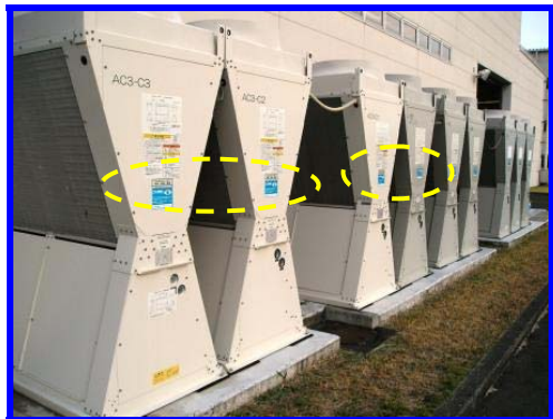
場所：研究棟設備ハッケージ（室外機）
