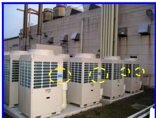
場所：研究棟設備冷凍機（室外機）
