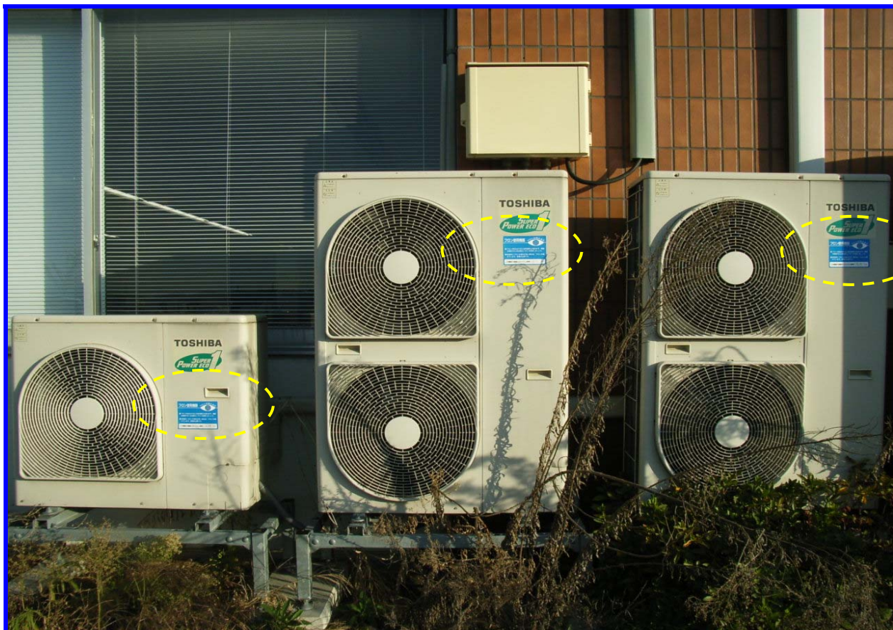
場所： ビル外側（室外機）全景
