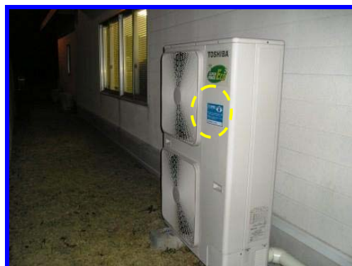
場所：組合事務所（室外機）
