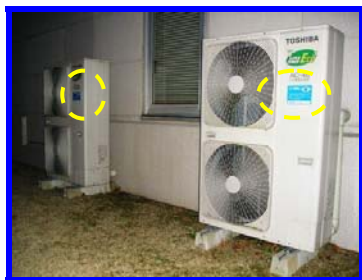
場所：事務棟 1F 東（室外機）
