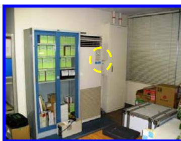
場所：コンピュータ室（室内機）
