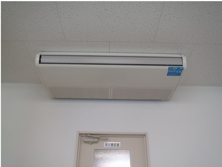
延岡市内・事務所・エアコン室内機 見える化シール貼り付け
