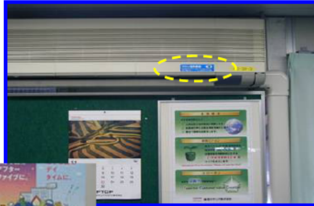
■室内機 会議室
