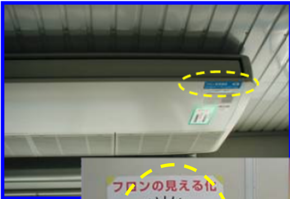
■室内機 事務所
