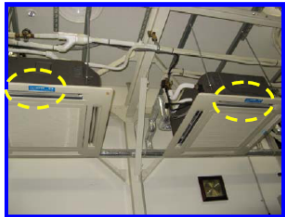
■室内機 実習室
