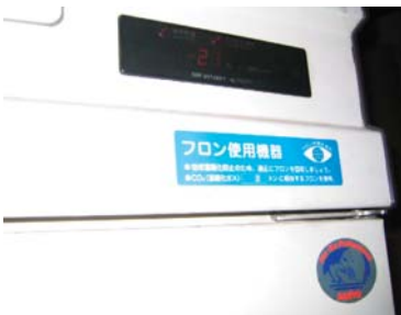
⑦縦型冷凍庫
