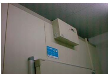
③オープンウォークイン冷蔵庫 扉上
