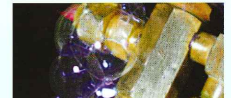
発泡液で漏えいを確認
