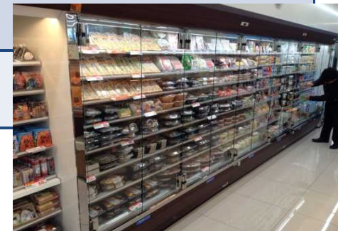
省エネ型自然冷媒機器のショーケースに扉を設置した例(ローソンパナソニック前店)
