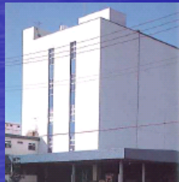
冷凍冷蔵倉庫
