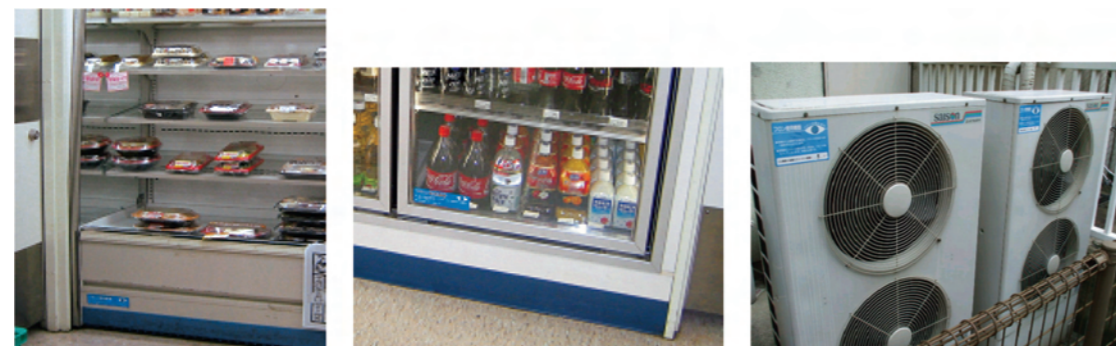
シール貼付状況
